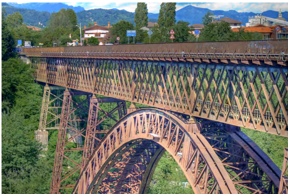
Figura 12, ponte di Paderno d'Adda (LC).
