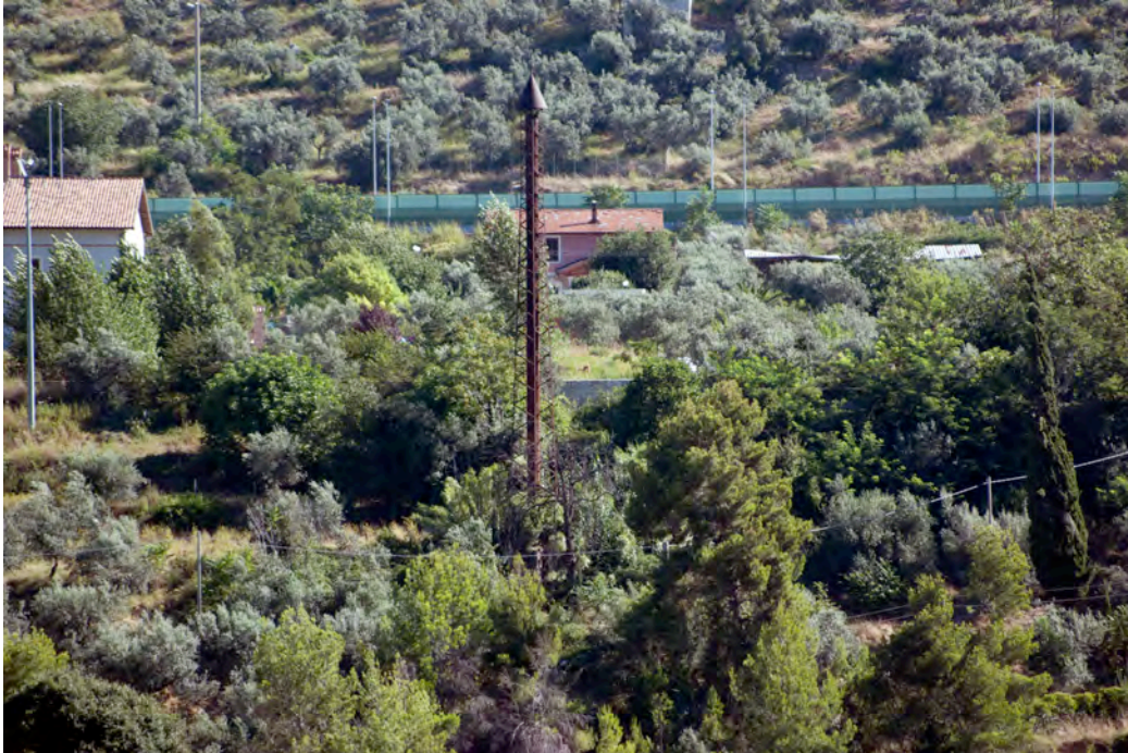
Figura 9, colonna di aspirazione per impianto di frazionamento dell'aria.
