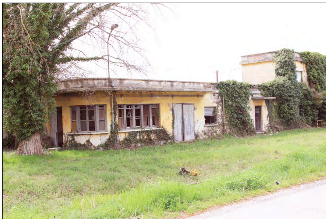
STAZIONE INGRESSO MATERIALE ROTABILE, 2015.
