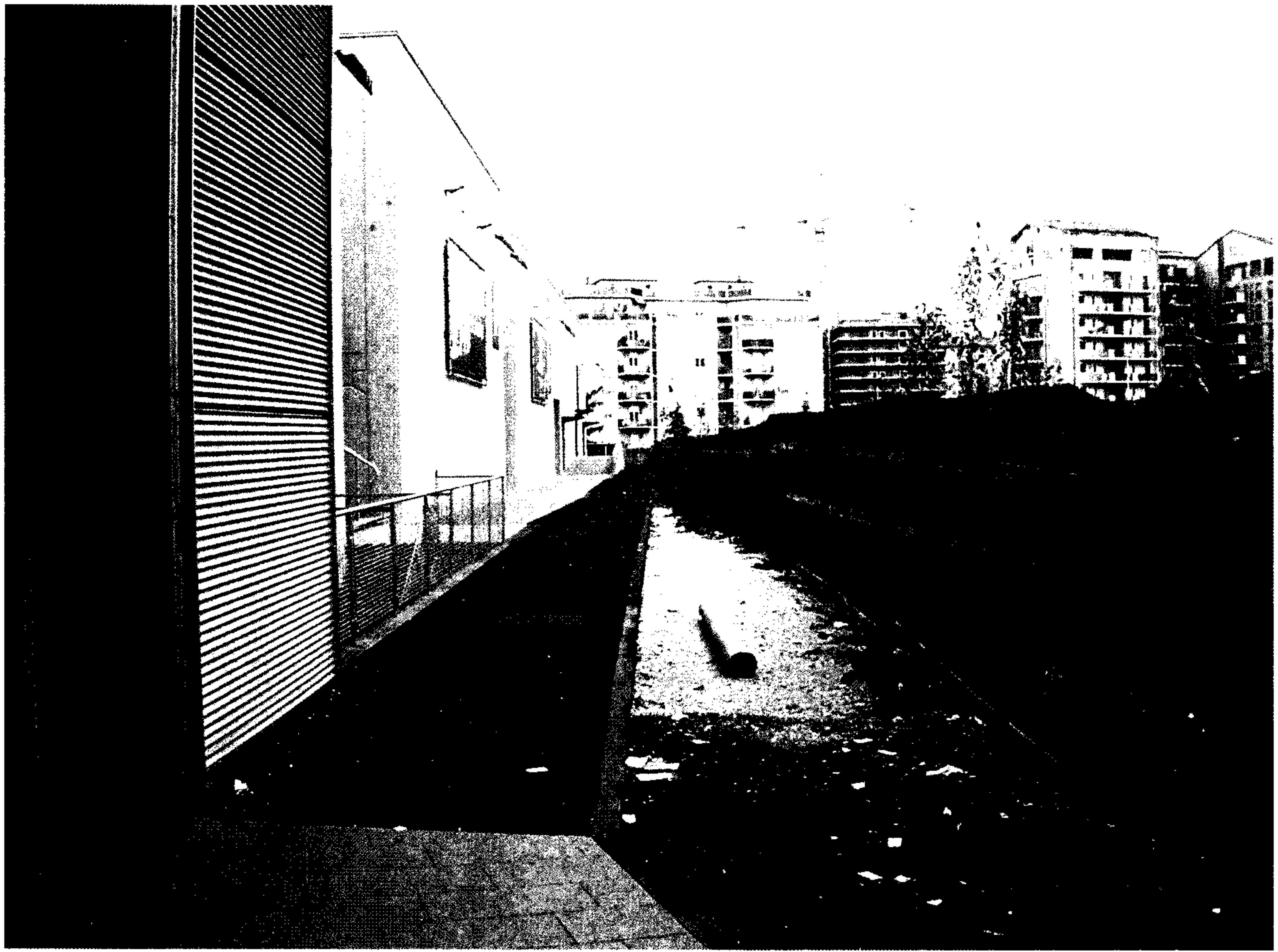
IL FRONTE LUNGO LA MULTISALA
