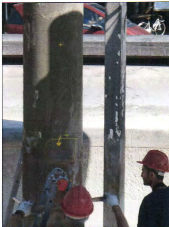
Foto - Ispezioni stato conservazione
