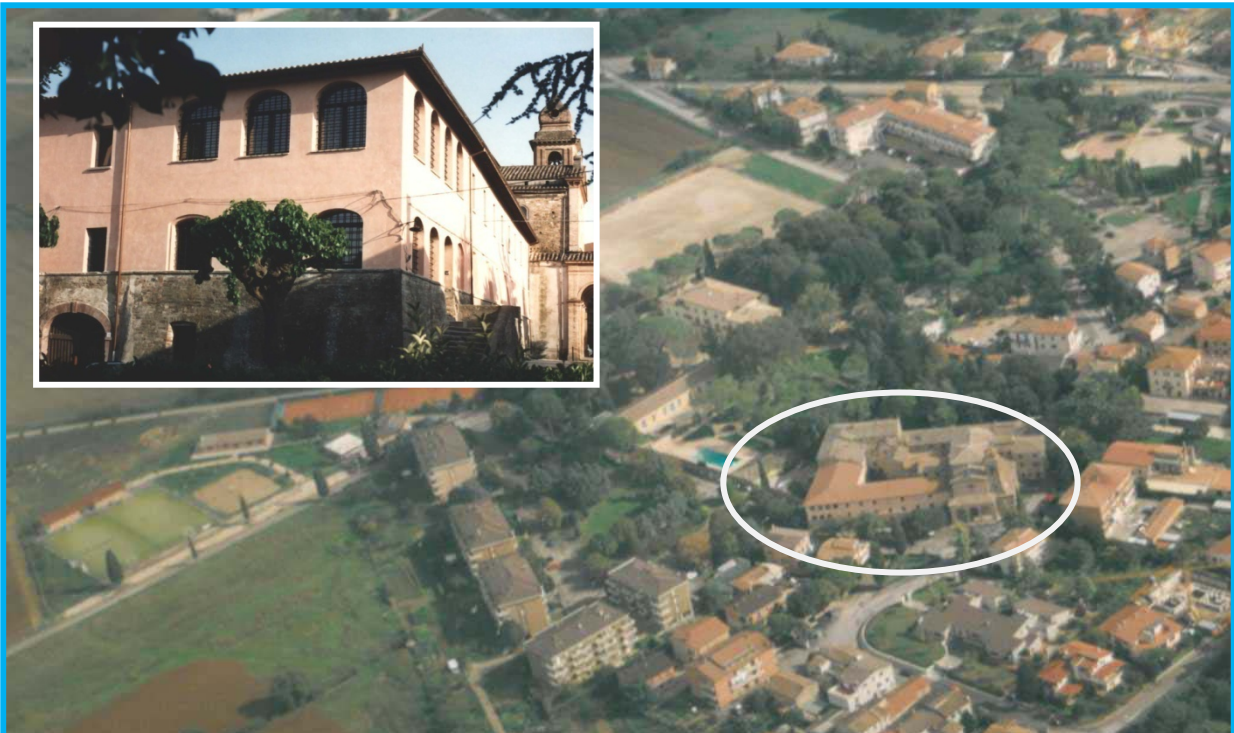
La sede della Società è in un edificio storico ubicato in Umbria nei pressi dell' aeroporto regionale
