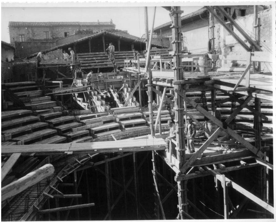
Immagine del cantiere del 1947-48 Realizzazione della prima galleria in struttura in c.a. fino alla controfacciata polettiana.
