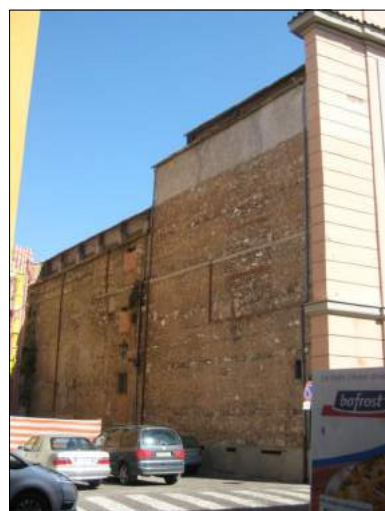
VISTA FACCIATA ANGOLO VIA SANT'AGAPE
