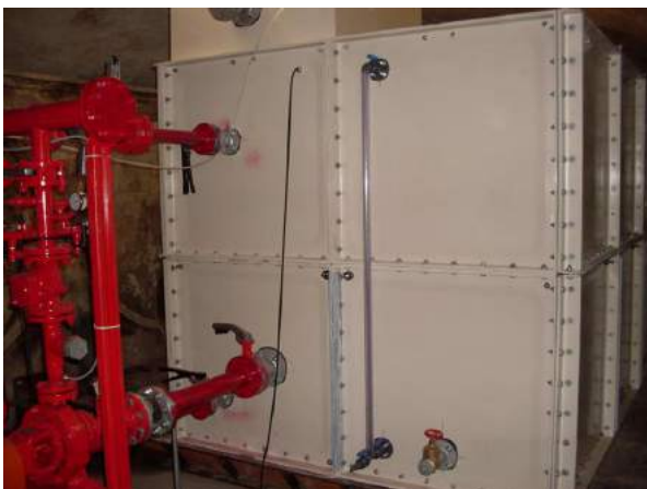
Impianto di accumulo e pressurizzazione antincendio
