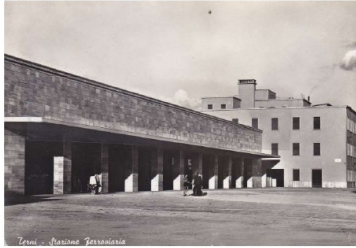
Terni - Stazione Ferroviaria Immagine di archivio
