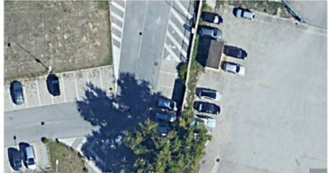
Sito di intervento ex ante - fuori scala
