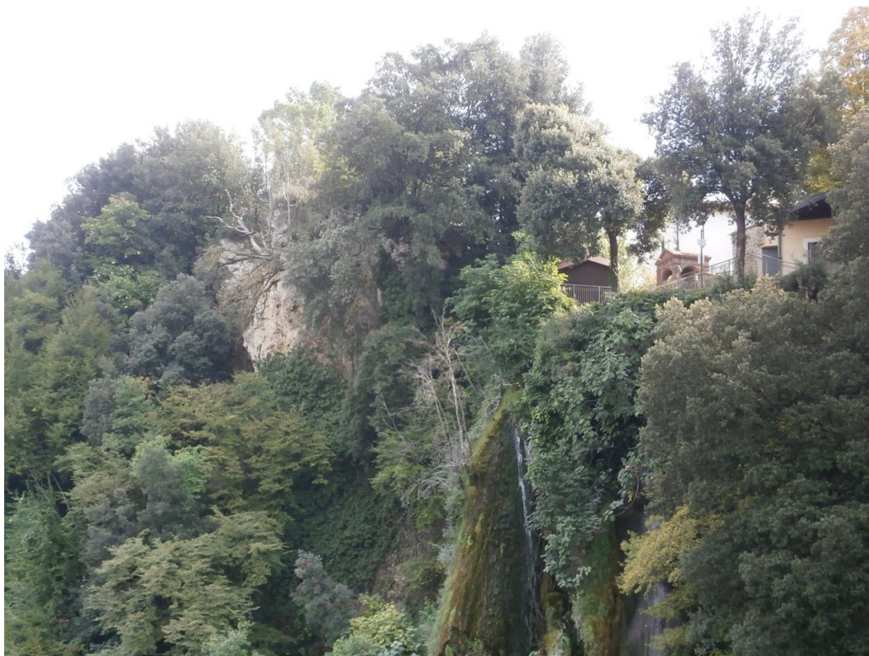
FOTO 1- zona aggettante prospiciente il Salto Principale.
