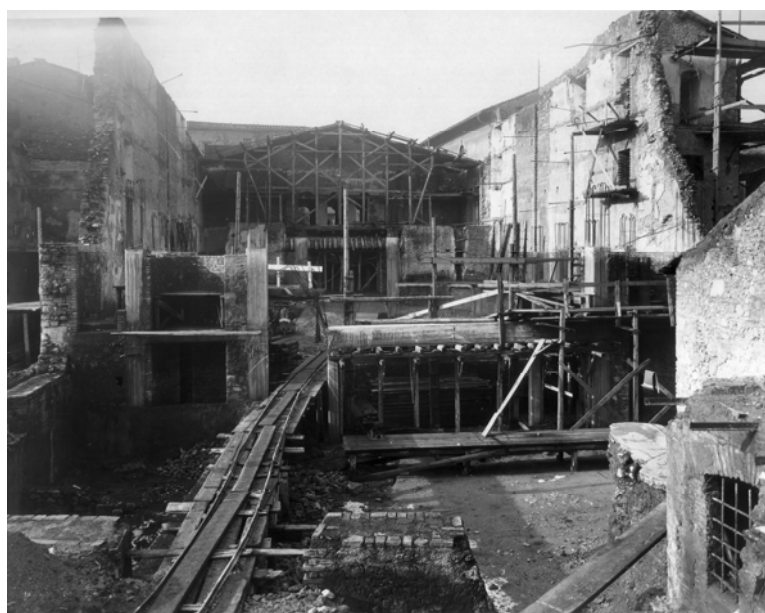
Immagine del cantiere del 1947-48 (vista dalla torre verso la controfacciata)
