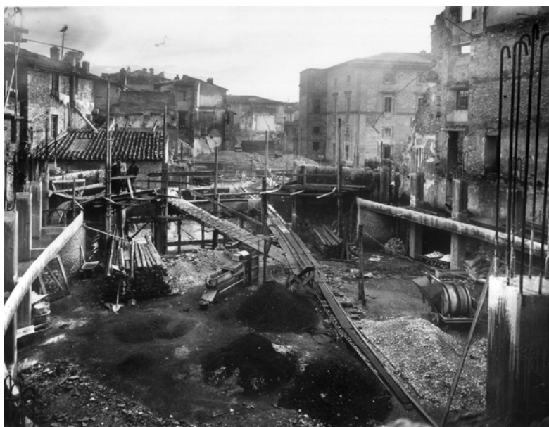
Immagine del cantiere del 1947-48 (vista dalla controfacciata verso Vico Sant'Agape)
