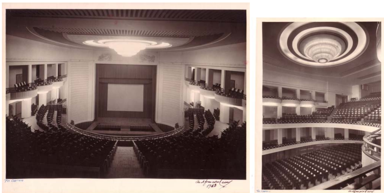
Figura 15 – A sinistra, veduta della sala con schermo del cinema (1948); a destra, veduta della sala dal secondo ordine di palchetti
