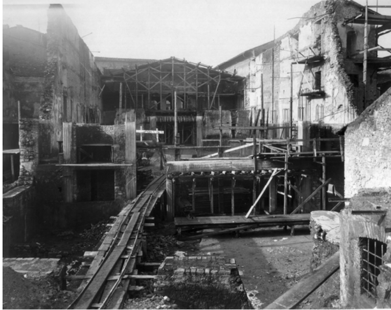
Immagine del cantiere del 1947-48 (vista dalla torre verso la controfacciata)
