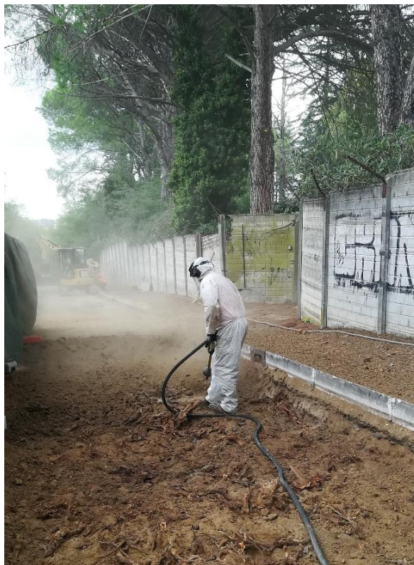
Foto 1 Intervento di escavazione con Air Spade
