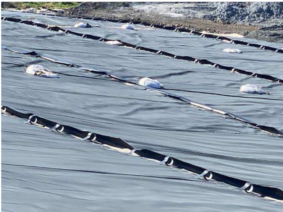
Foto 4 – Sistema gestione allontanamento acque meteoriche sulle scarpate
