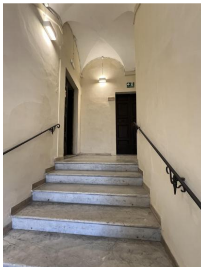
Figura 41 – Le porte di distribuzione al piano secondo
