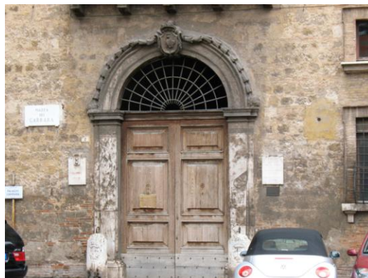
Figura 38 – Il portone ligneo di Palazzo Carrara
