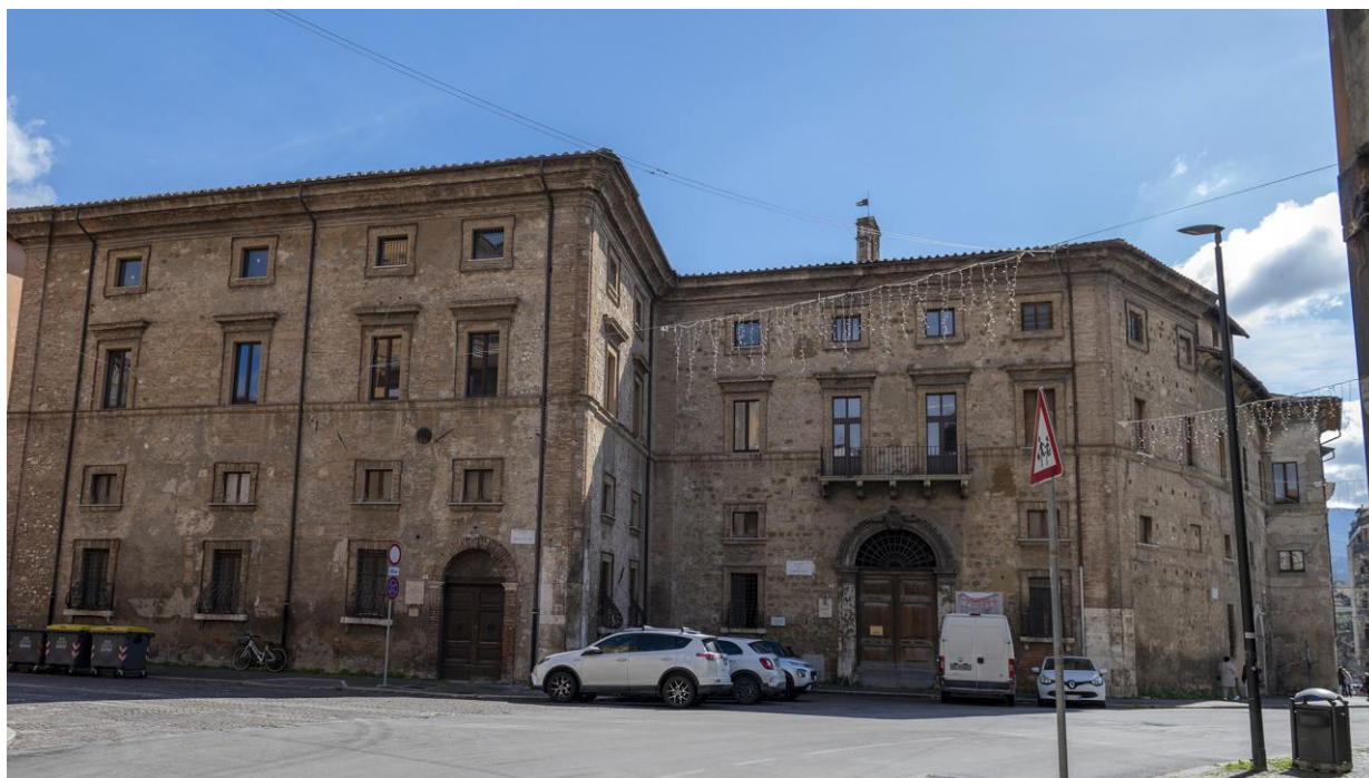
Figura 15 – Vista dal basso del complesso Carrara
